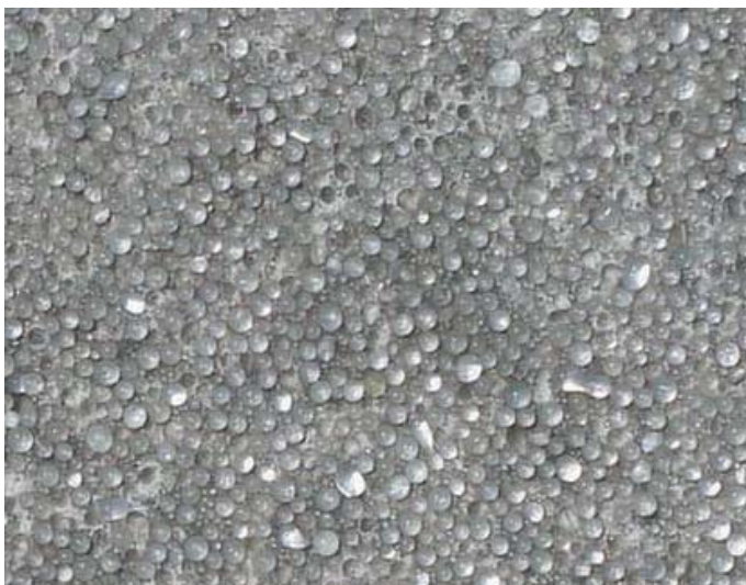
Obrázek 3 – Příklad nedostatečného zabudování materiálu na dodatečný posyp
